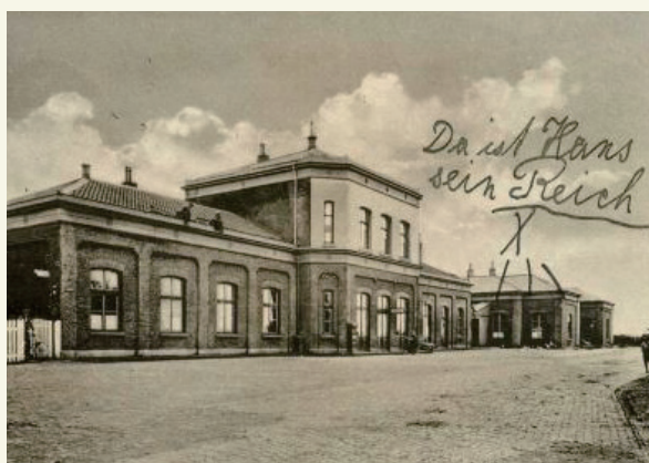
당시 노이샨츠 역의 전경
